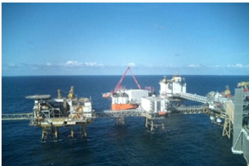
Bilde 4.4.4e – Vedlikehold HVAC anlegg for ConocoPhillips
