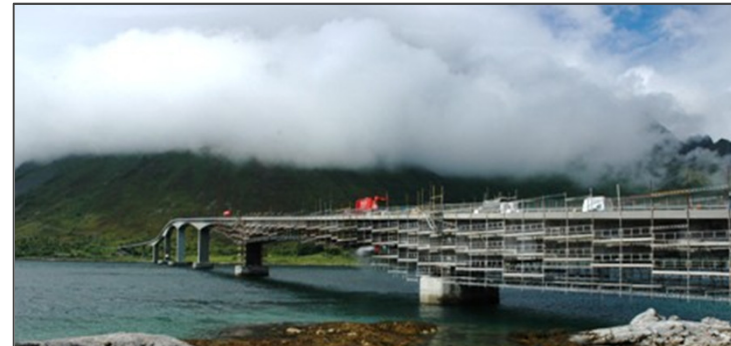
Rehabilitering med katodisk beskyttelse
