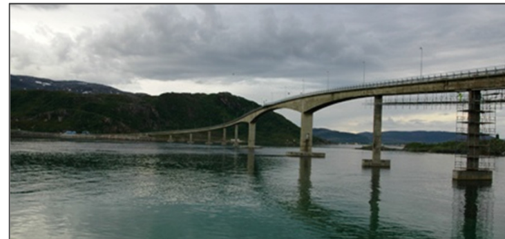
Rehabilitering med katodisk beskyttelse
