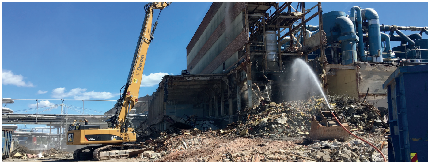
Maskinell riving av industrianlegg for Borregaard
