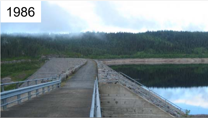
The Dokkfløy dam, NOK 350 m
