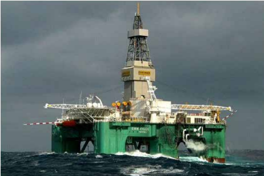
The Leiv Eiriksson drilling rig.
