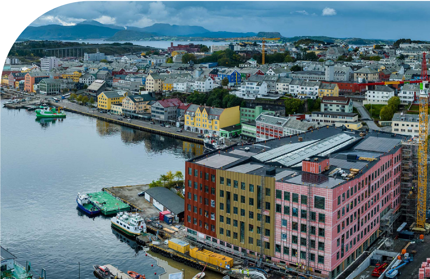
Kristiansund - bygging av Campus Foto Per Kvalvik
