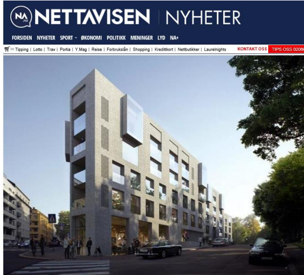
Pilestredet 77 er et av Oslos nye boligprosjekt. Her er 28 leiligheter revet vekst. Foto: Aspin Ramm
