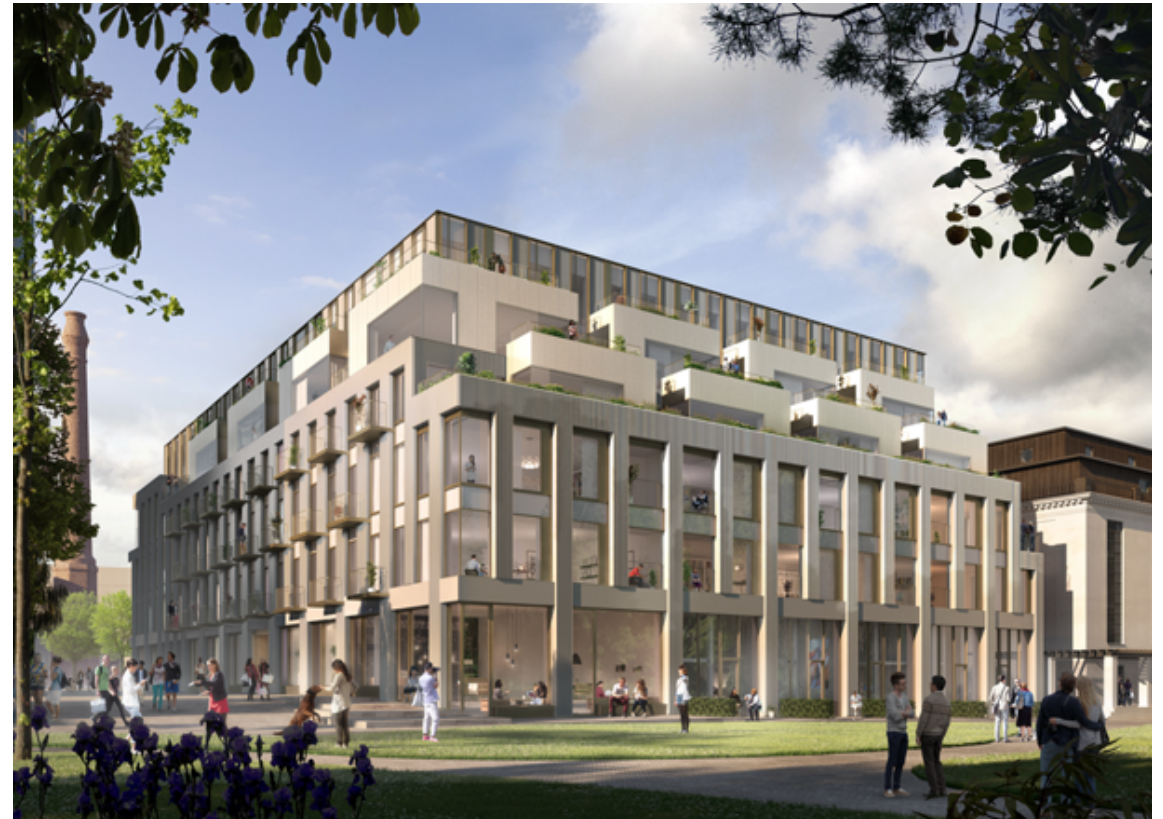
Veidekke bygger Mineralvandsfabrikken i sentrale København med næringslokaler og boliger
