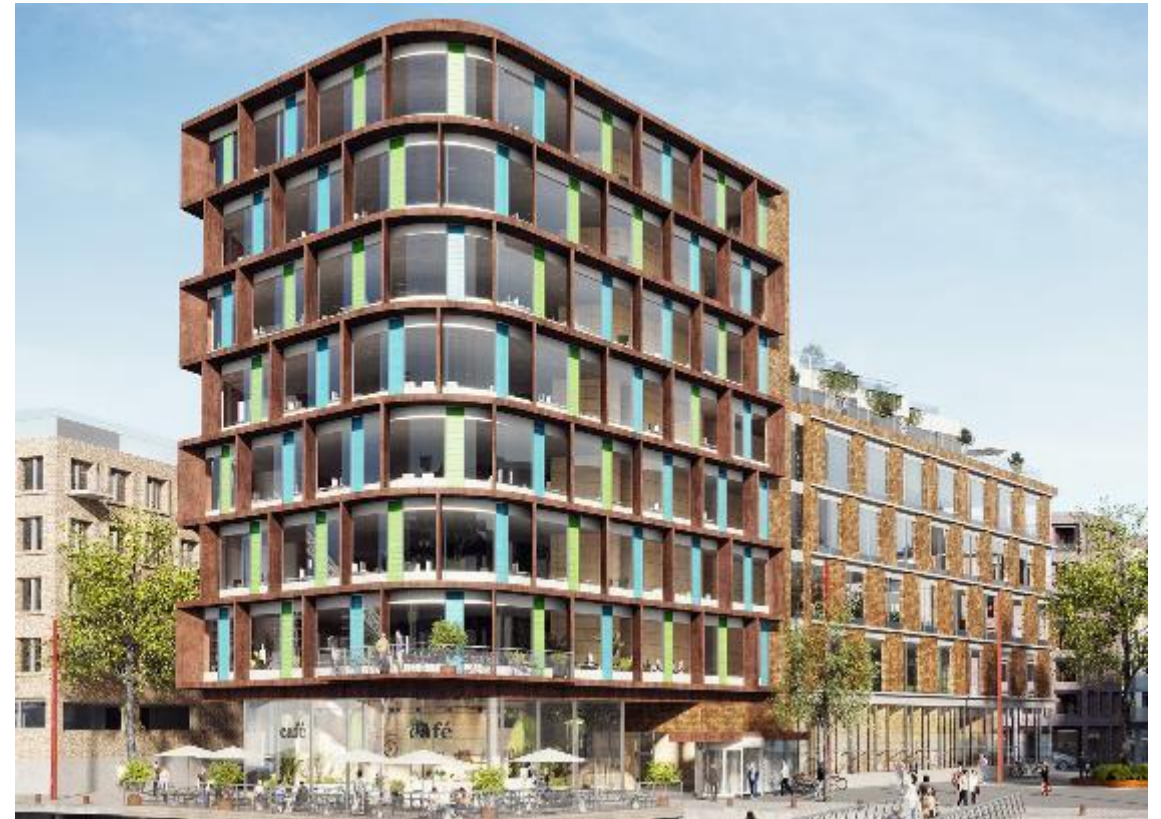
Veidekke bygger prosjektet GreenHaus, et kontorbygg i Oceanhamnen i Helsingborg, Sverige
