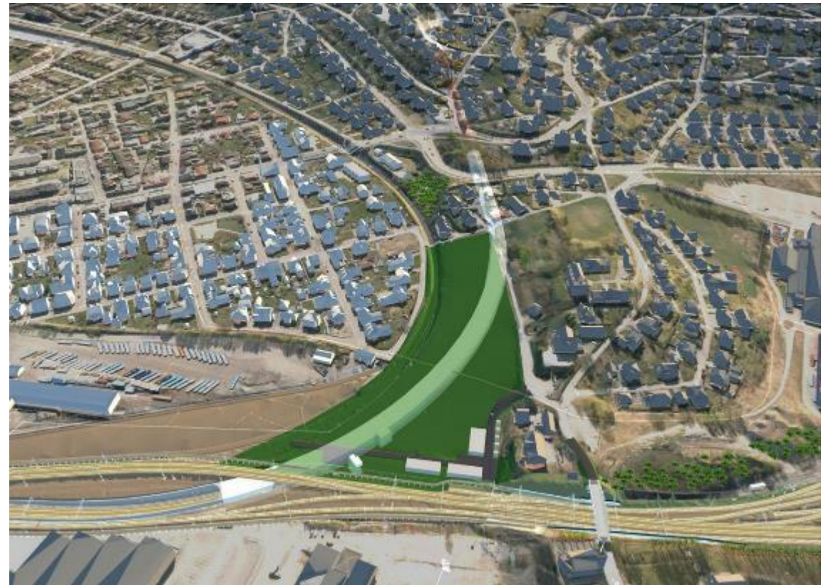
Veidekke har inngått to kontrakter med Bane NOR om bygging av blant annet ny dobbeltsporet bergtunnel og løsmassetunnel på Vestfoldbanen. Kontraktene er totalentrepriser med samlet kontraktsverdi på om lag NOK 3,8 milliarder © Veidekke
