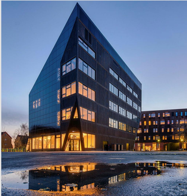
ZEB Flexible Labs i Trondheim. Bygget er en Zero Emission Building med nivå COM, som betyr at i et 60-årsperspektiv skal CO 2 -utslippene kompenseres med produksjon av fornybar energi ved hjelp av solceller.
