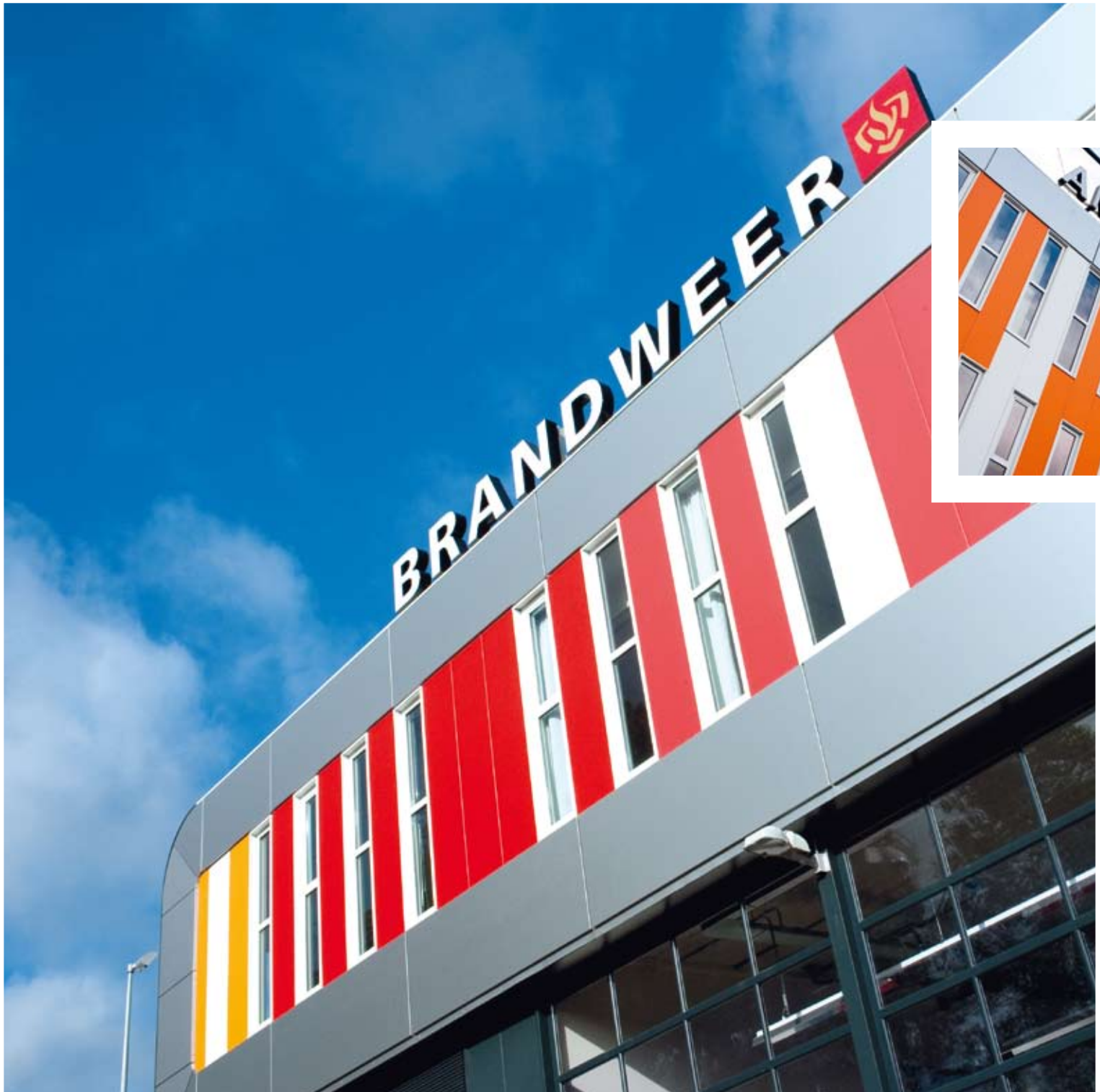
Brandweer- en ambulancepost, Den Haag. BAM Utiliteitsbouw.
