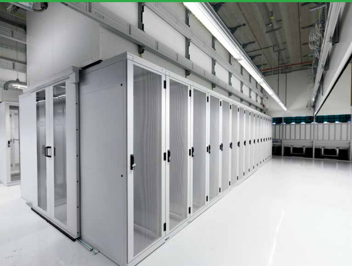
BAM Techniek en BAM Utiliteitsbouw. Ontwikkeling en realisering datacenter voor The Datacenter Group, Delft.
