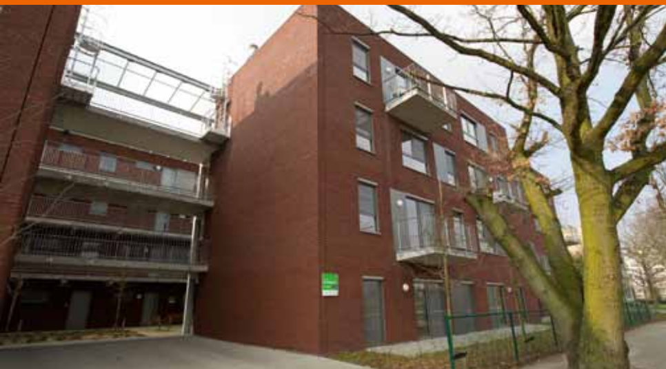
Kairos, Interbuild, BAM Woningbouw. 193 serviceflats Gallifort, Deurne, voor Zorgbedrijf Antwerpen.
