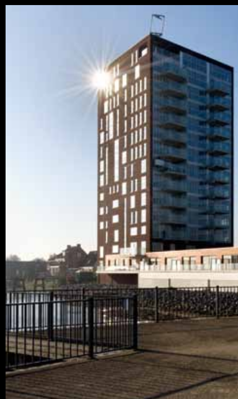
AM, BAM Woningbouw. Het Bordes, 39 appartementen, 2 penthouses, 6 kadeappartementen en een halfverdiepte parkeergarage, Ridderkerk.
