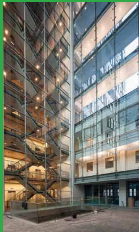
BAM Utiliteitsbouw (in combinatie), BAM Techniek. Erasmus MC, Rotterdam.
