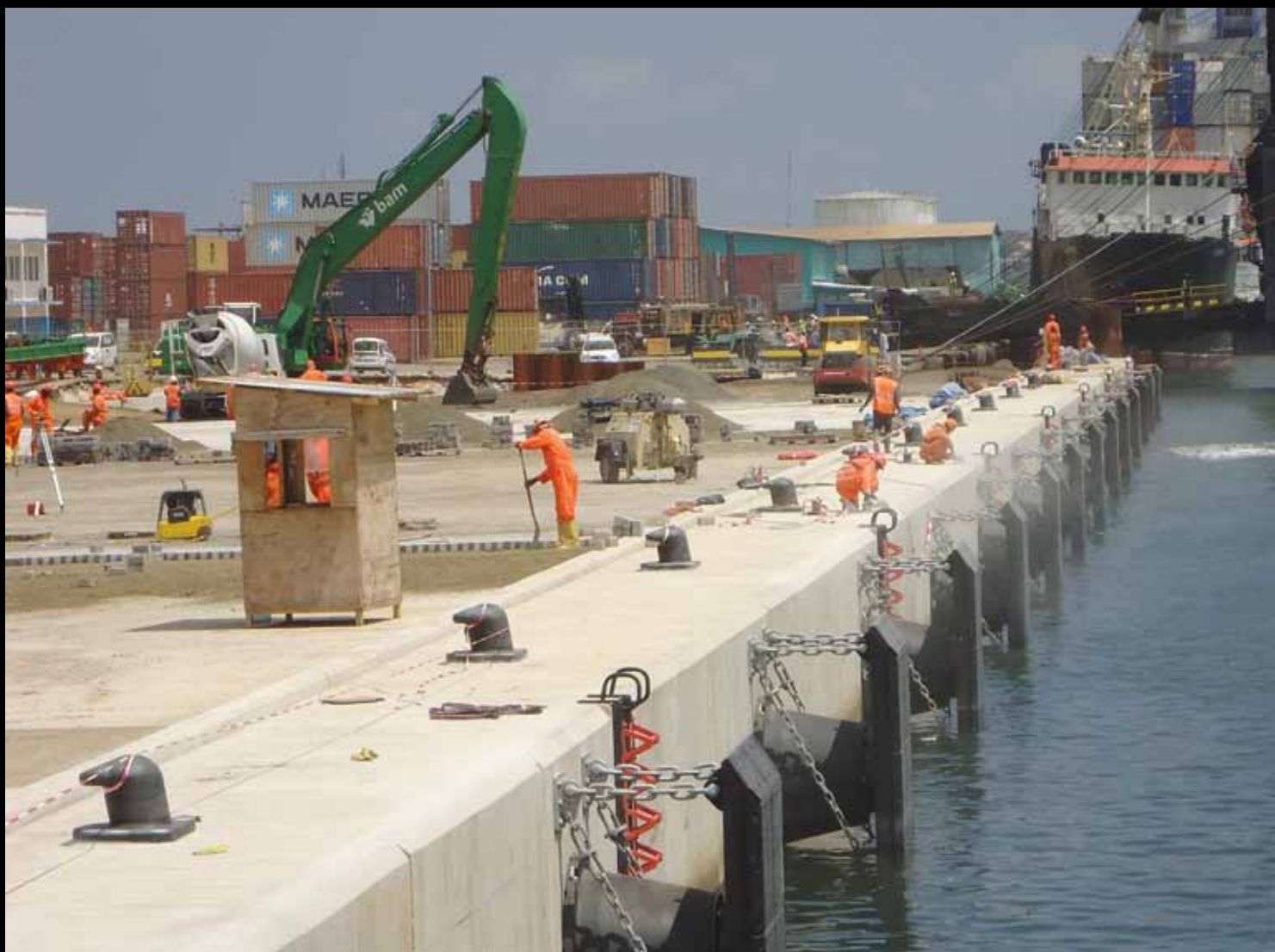
BAM International, BAM Infraconsult. 600 meter lange kademuur voor containerterminal Monrovia, Liberia.
