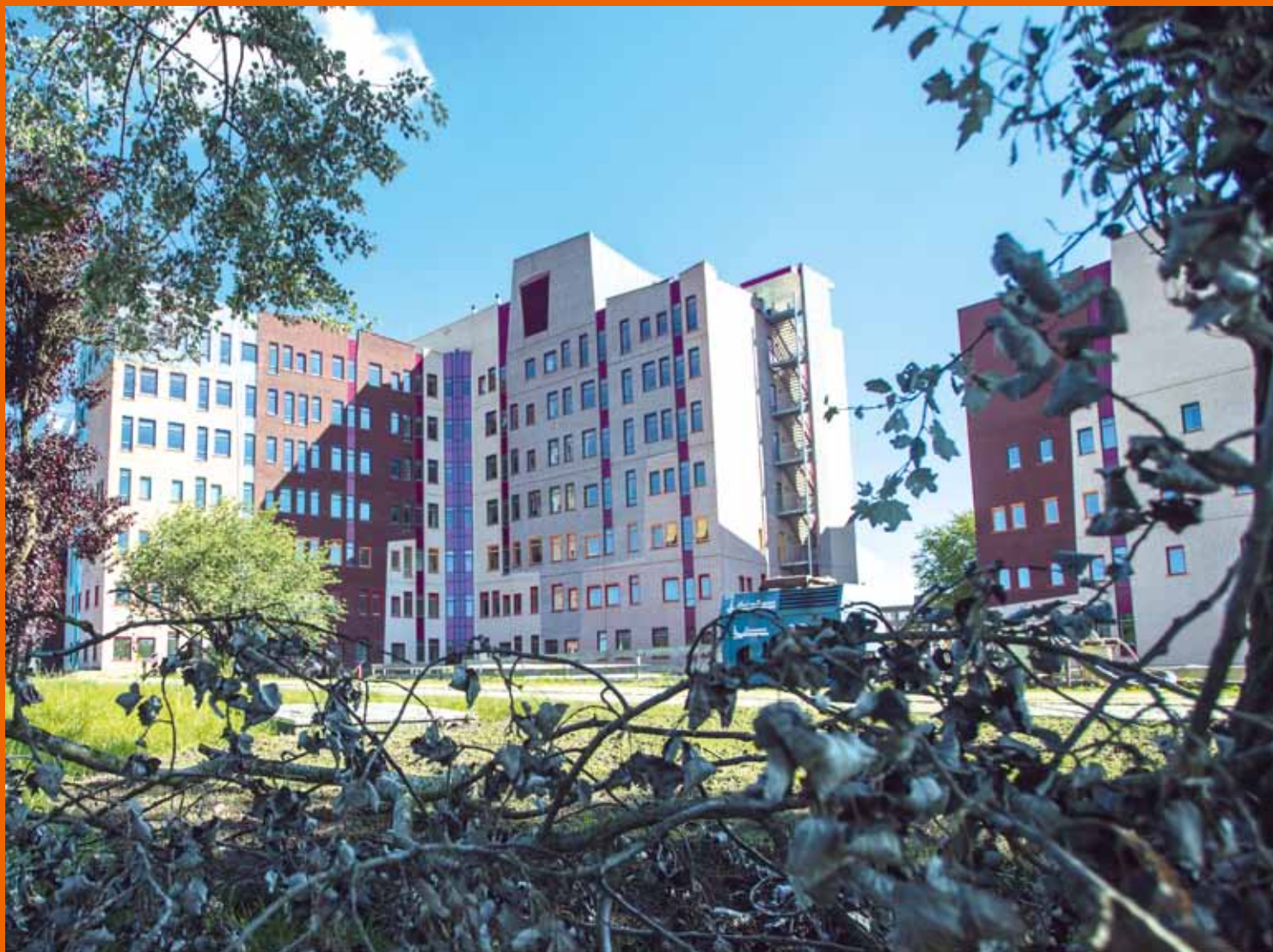
BAM Utiliteitsbouw, BAM Techniek, Interflow. Isala Klinieken, Zwolle. Architect: Alberts & Van Huut, a/d Amstel.
