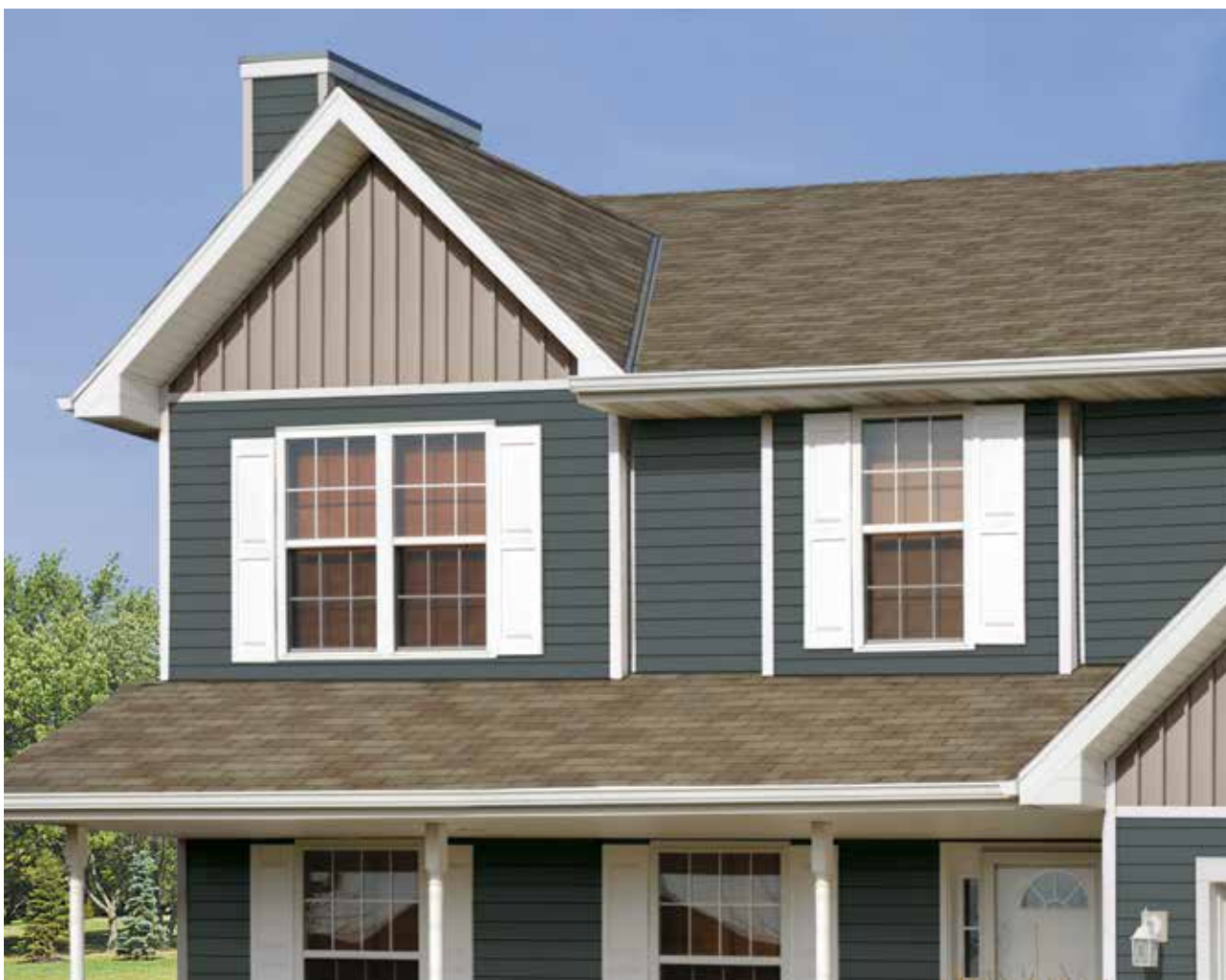
Klant gevelbekleding (Bouw & Constructie) Canada
