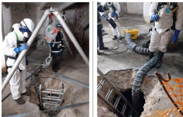
Saneringswerken in uitvoering.
