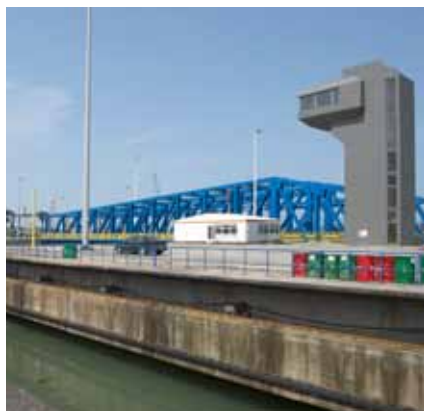
Infra Automation bij Pierre Vandammesluis (Zeebrugge)
