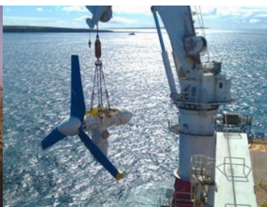
Installation d'une turbine pour énergie marémotrice
