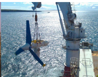
DEME - Installatie van een getijdenenergeturbine
