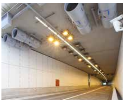
Tunnel R11 - Deurne
