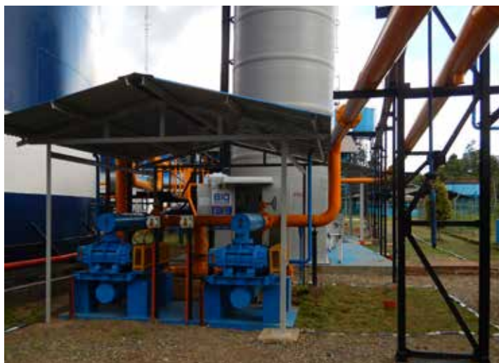
SIPEF - Détail d'un réacteur anaérobie et d'un épurateur de gaz chez Agro Muko
