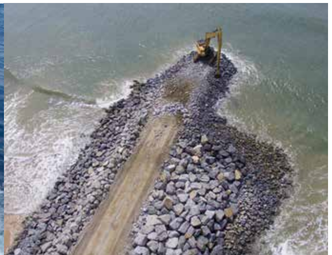
DEME - Construction d'un brise-lame en guise de protection contre la hausse du niveau de la mer au Bénin
