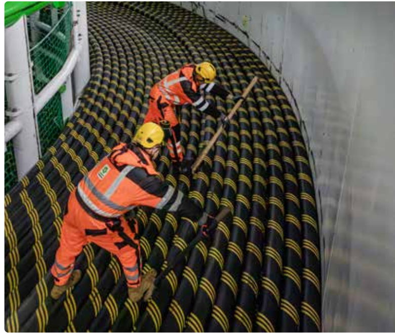
DEME • Kabelinstallatievaartuig 'Viking Neptun'
