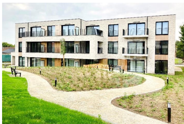
Sorgvliet in Linter (BE) Uitbreidingsproject voltooid op 9 juli 2021
