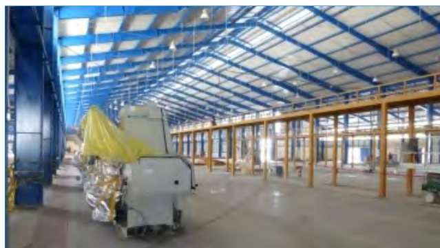
Dramix® fabriek Costa Rica: Bekaert voorziet het gebouw van de nodige infrastructuur. We verwachten dat de fabriek operationeel zal zijn in het tweede kwartaal van 2014.
