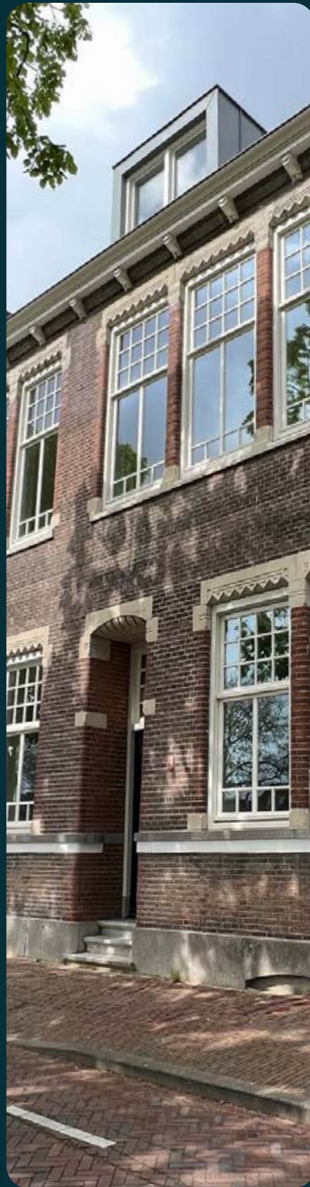
Middelburg (NL) - Sterrenwacht
