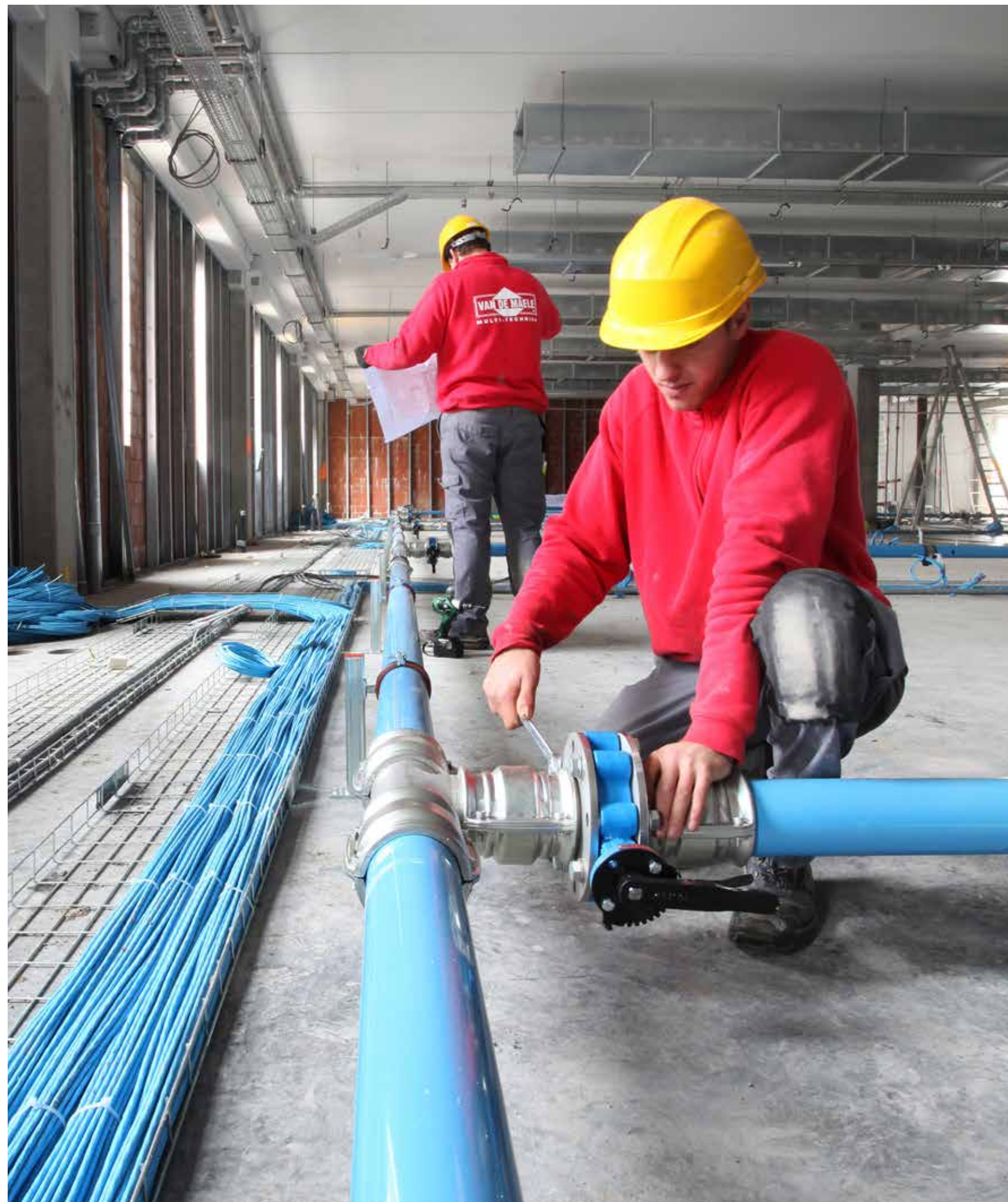
▲ Pose de canalisations d'air comprimé et sous vide - leper
