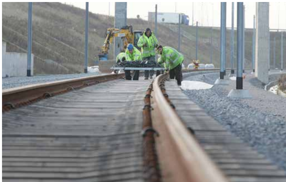
Pose de voies ferroviaires
