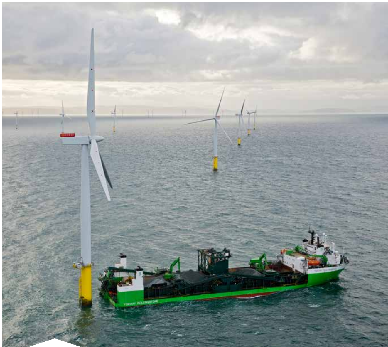
Eind 2013 sloot GeoSea een EPCI-contract af voor het ontwerp, de levering en de installatie van de funderingen van 15 windturbines omtrent de uitbreiding van het Kentish Flats offshore windmolenpark van Vattenfall.
