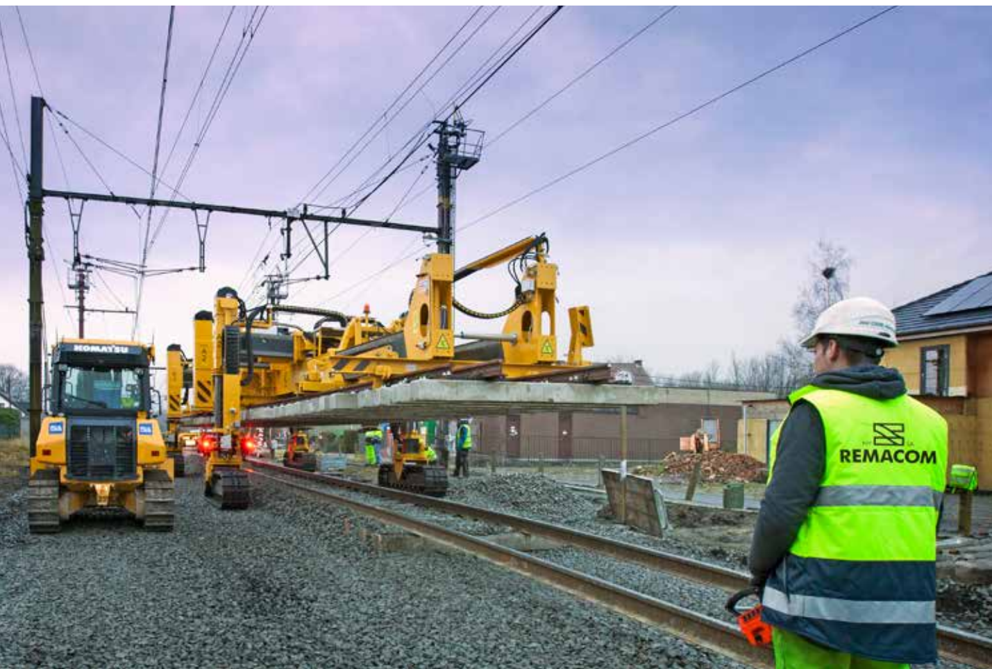
Une machine de pointe pour le remplacement des aiguillages.
