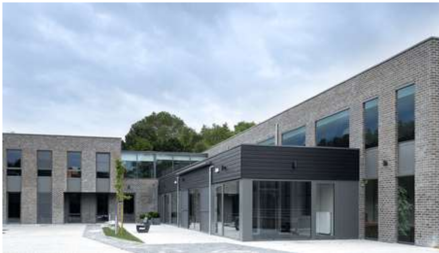
► Maison de repos et de soins Noordduin - Coxyde (BE)
