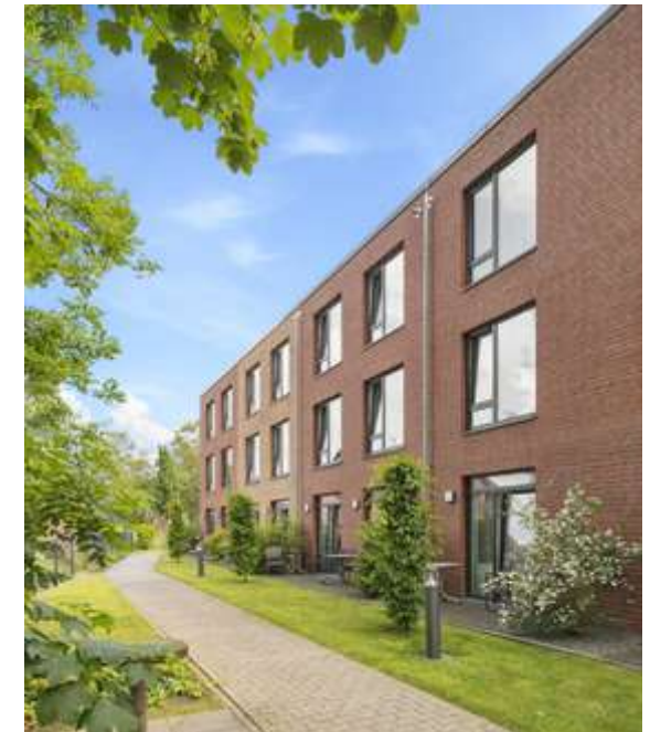
► Maison de repos et de soins – Aurich (DE)
