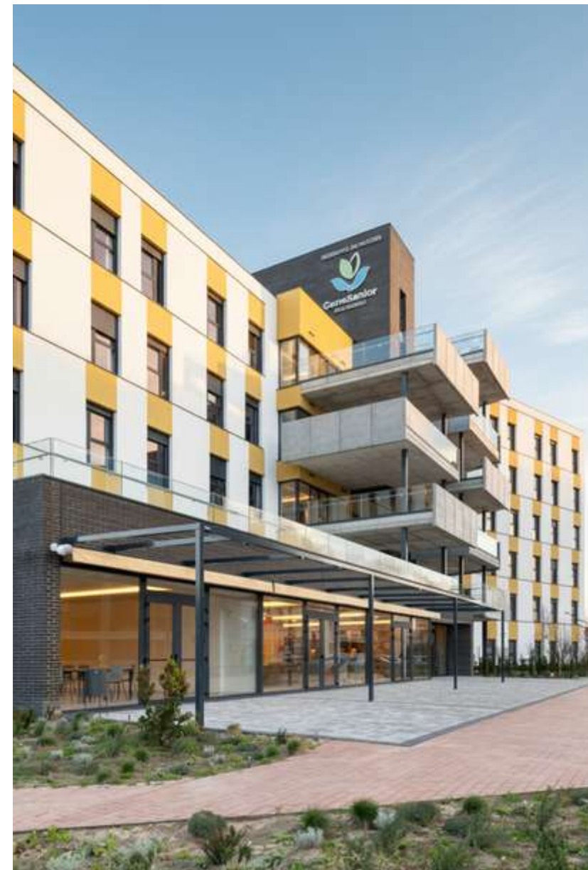
► Maison de repos et de soins - Valladolid (ES)
