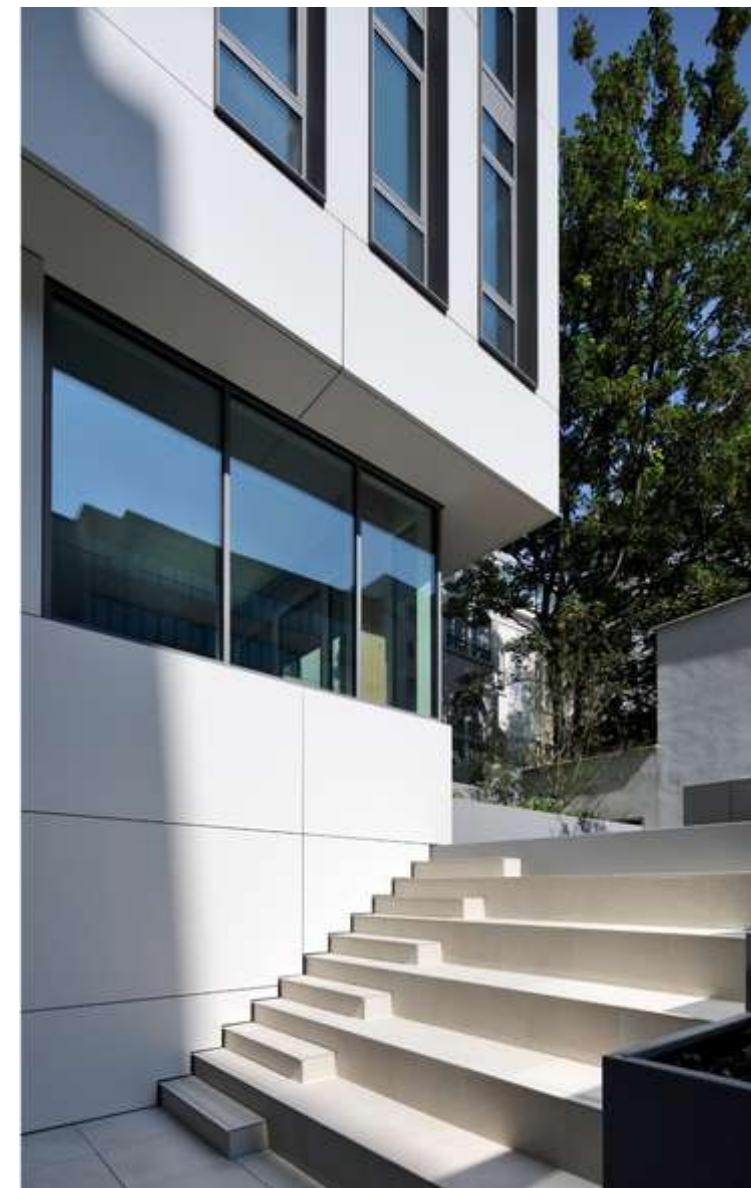
► Immeuble de bureaux Montoyer 10 (M10) - Bruxelles CBD (BE)
