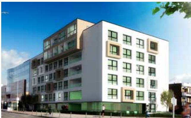
→ Project Maurice Charlent (Oudergem)
