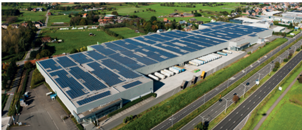
▲ Boven: kantoren - Mechelen Campus. Onder: logistiek - Puurs
