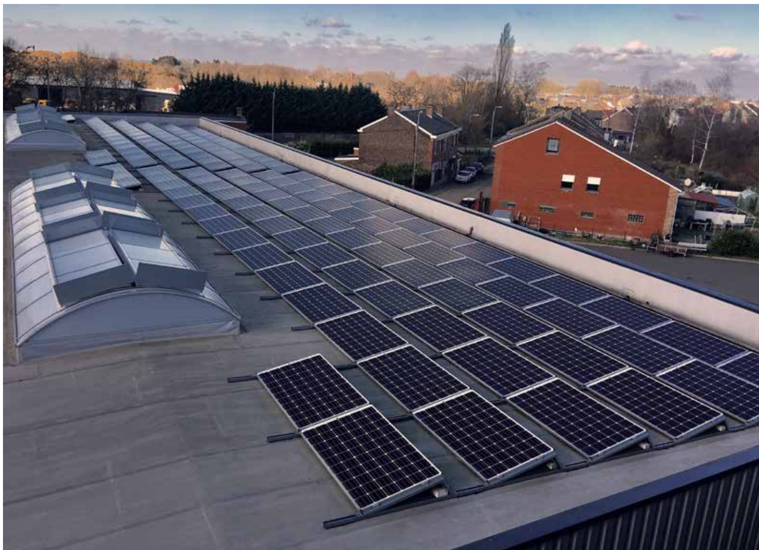
Panneaux photovoltaïques installés sur le toit du nouveau hall à Romsée
