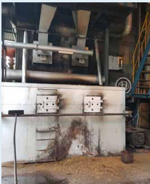
Portes du foyer d'une chaudière
