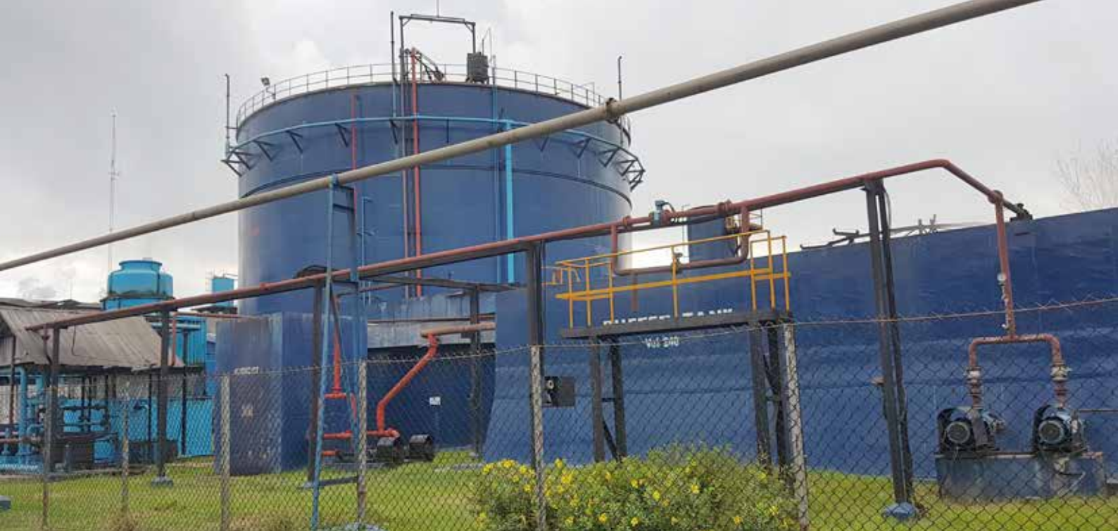
Réservoir-réacteur anaérobie (centre), et une partie des installations de capture de méthane
