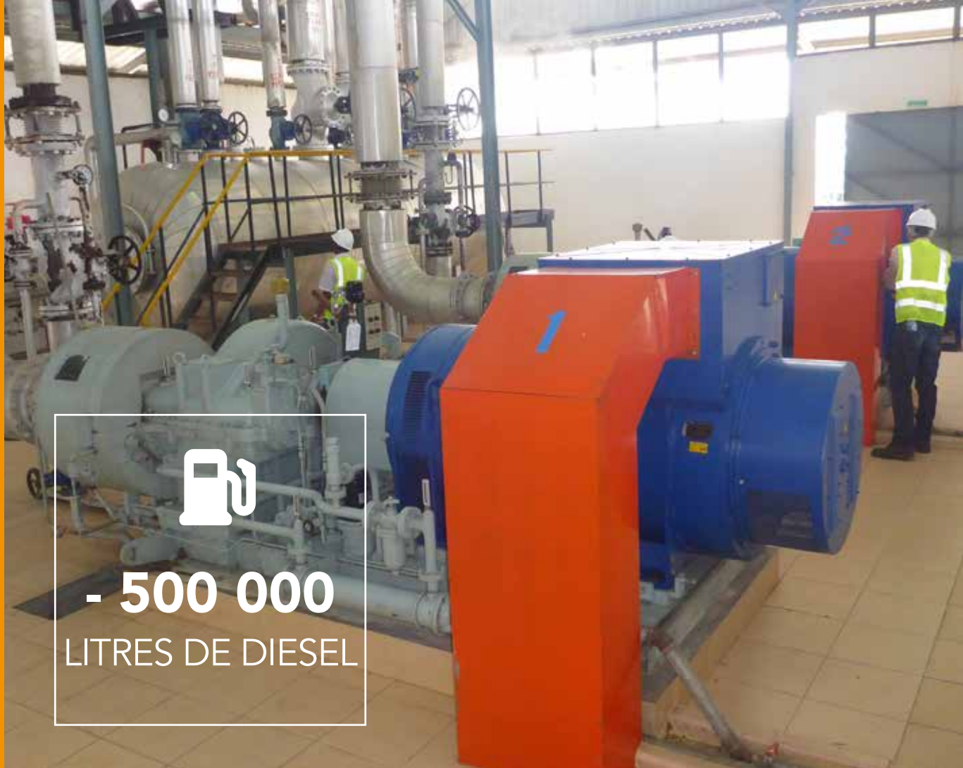
Deux turbines à vapeur en avant-plan, et le vase d'expansion de la vapeur en arrière-plan
