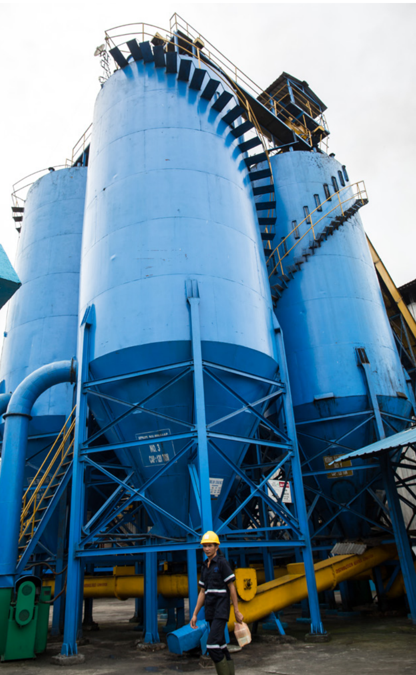
Silo's voor bulkopslag van palmpitten
