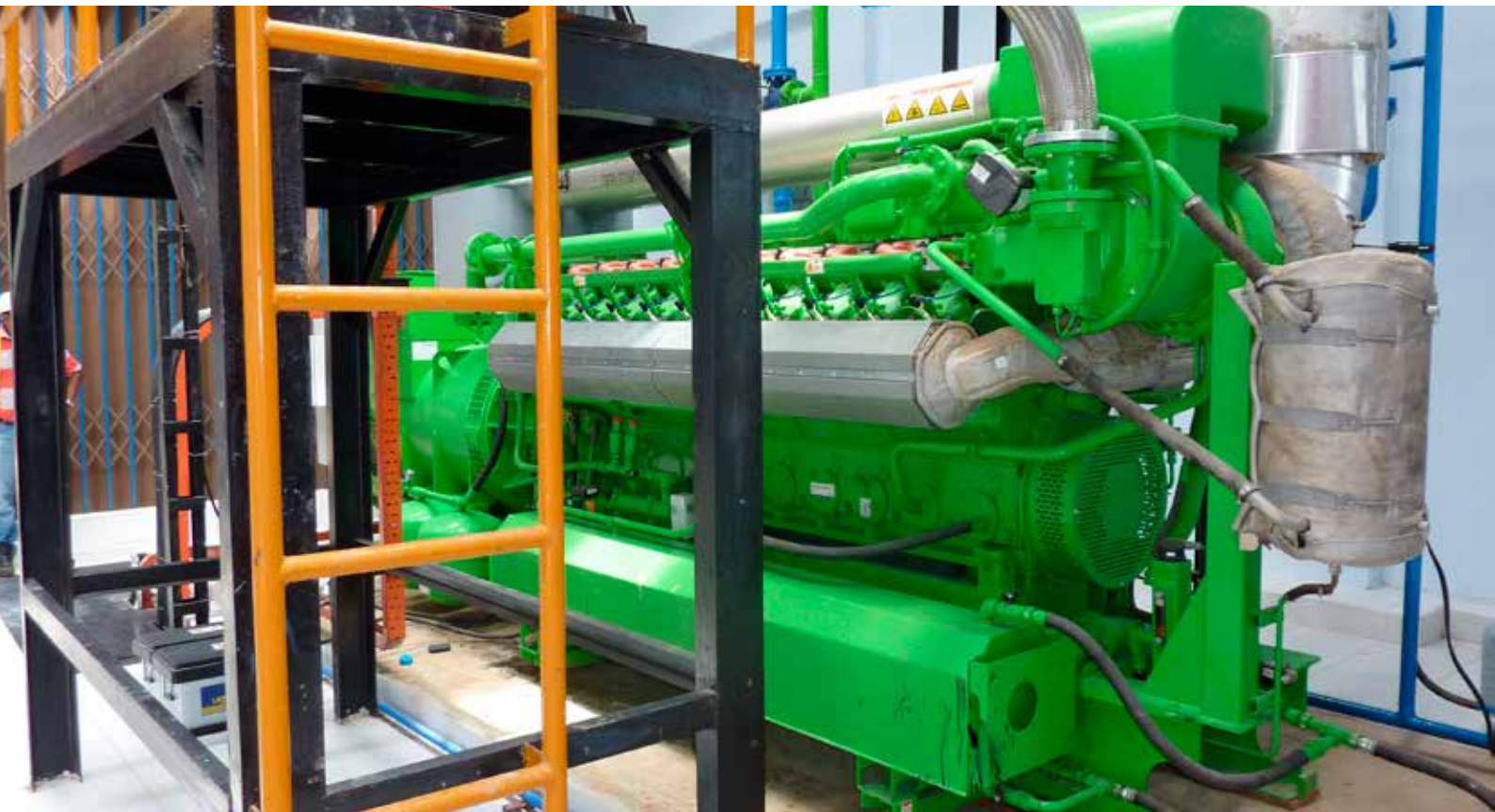
Biogasmotor in Mukomuko palmoliefabriek in Agro Muko in Bengkulu, Indonesië
