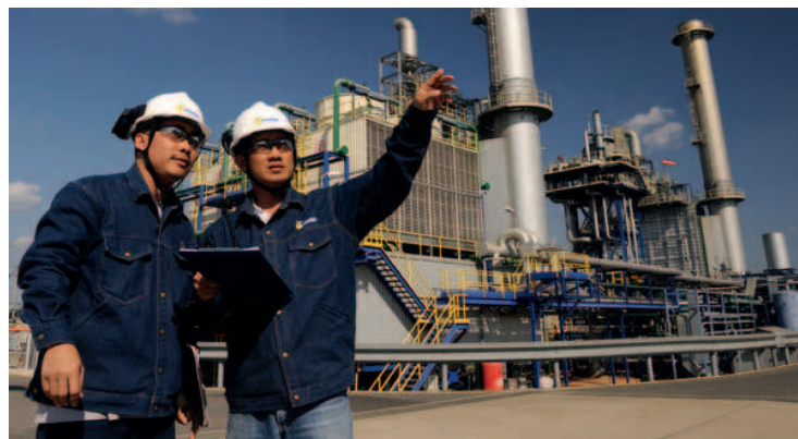
Thaïlande - Centrale électrique
