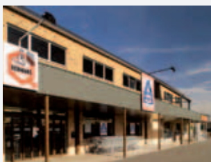
ALDI - RETAIL PARK FLEMALLE Rue de la Fabrique 6 Flemalle Oppervlakte / 1.015 m 2
