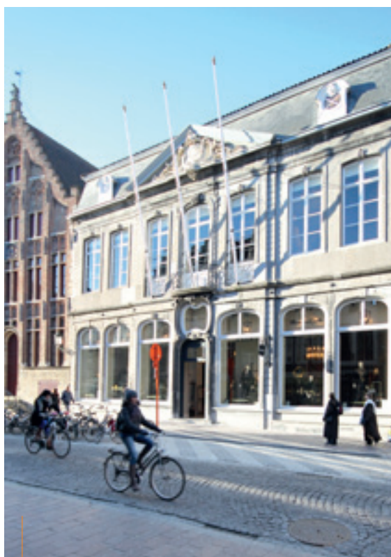
Brugge, Steenstraat - 941 m 2
