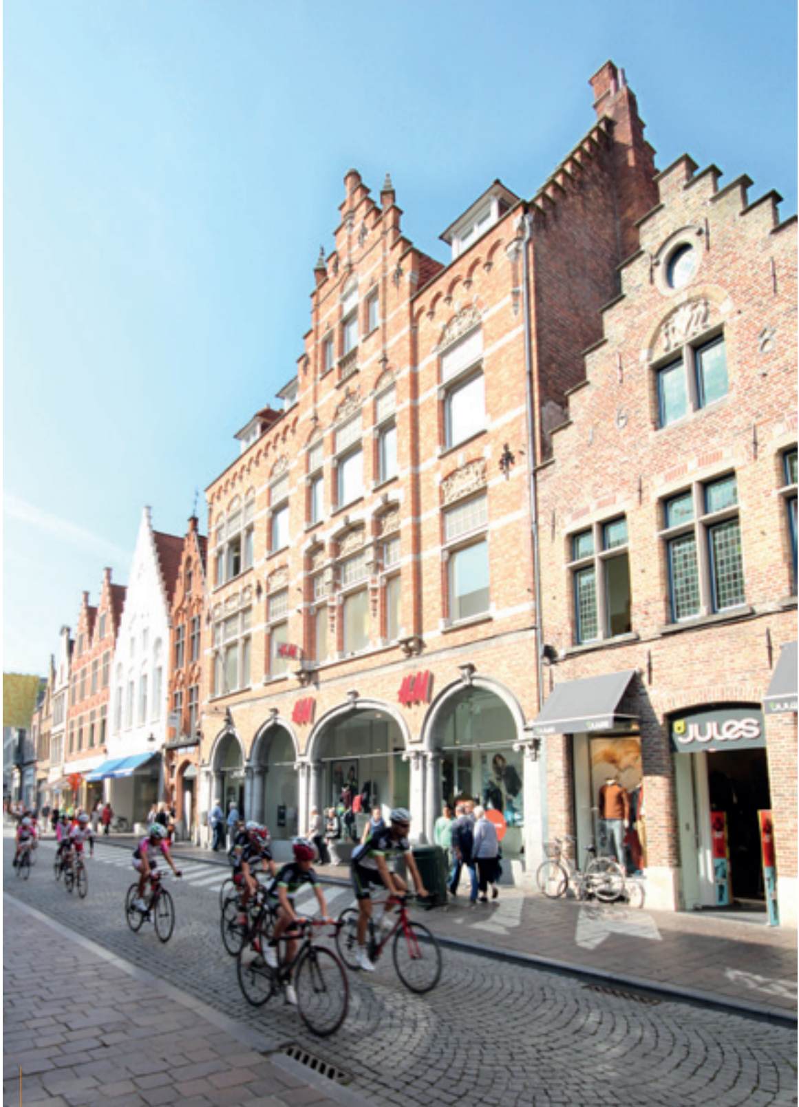
Brugge, Steenstraat - 2.058 m 2
