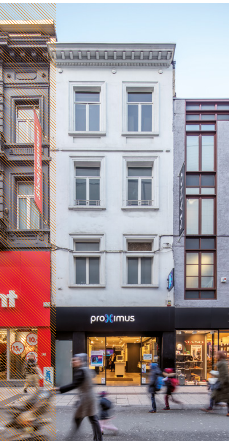
Brussel - Nieuwstraat - Proximus
