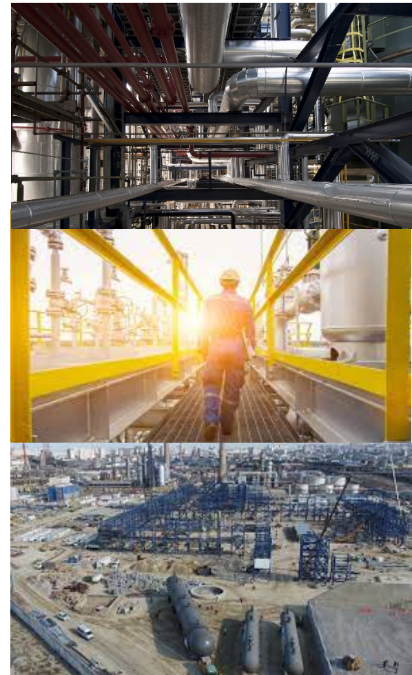
Source: Maire Tecnimont web-site
