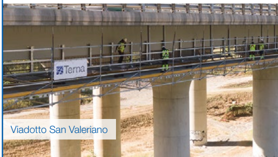
Posa dei cavi all'interno di un viadotto
