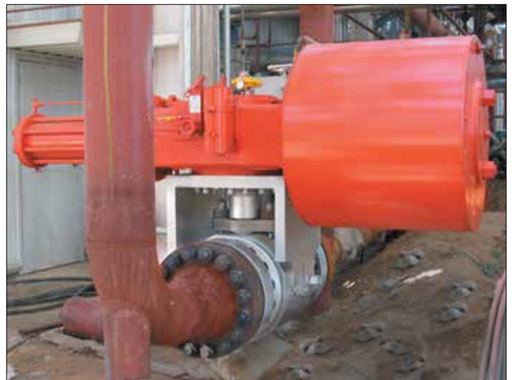
Un robinet à tournant sphérique à sièges métallique Velan à commande pneumatique utilisée pour isolement dans une unité d'hydrocraquage installée en Asie.
