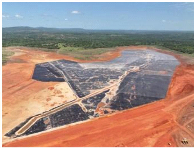
Figure 4 : Vue aérienne de l'installation de stockage des résidus miniers
