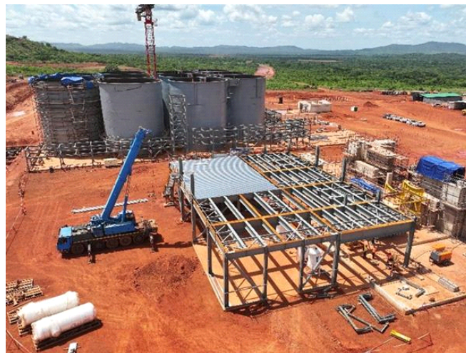
Figure 6 : Montage des cuves de broyage et de CIL
