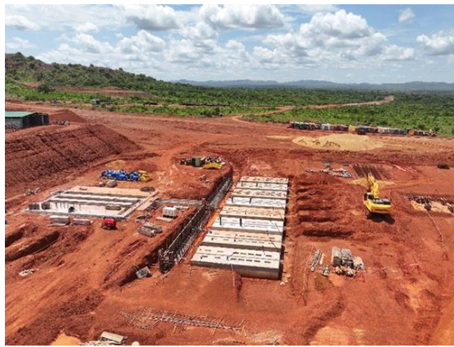
Figure 7 : Centrale électrique – Béton coulé pour 8 bases de moteurs
