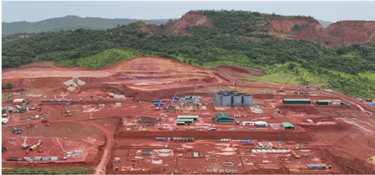
Figure 1 : Vue aérienne du site de Kiniéro présentant l'usine de traitement et les infrastructures (26 juin 2025)
