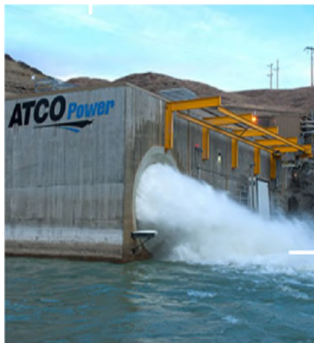
Centrale hydroélectrique d'Oldman River
