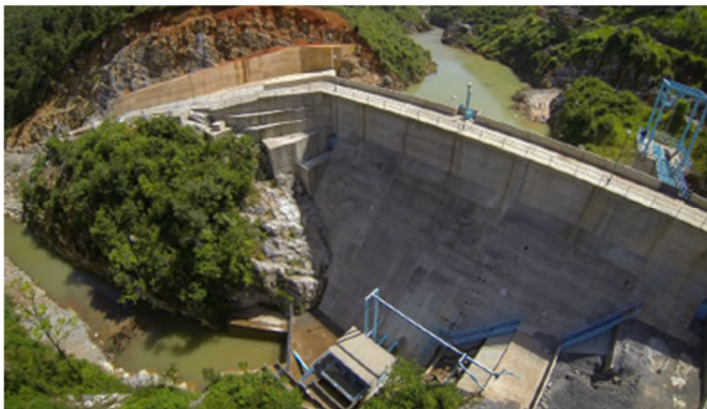
Centrale hydroélectrique d'Electricidad del Golfo.
