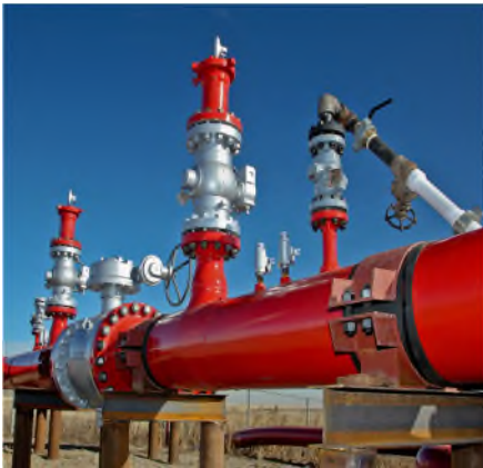
Assemblage d'une valve de pipeline de gaz naturel
