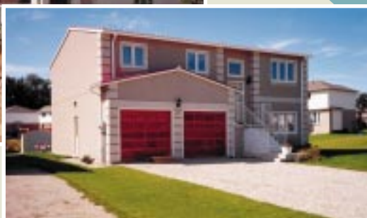
HABITATIONS Maison à deux étages en Ontario, au Canada
