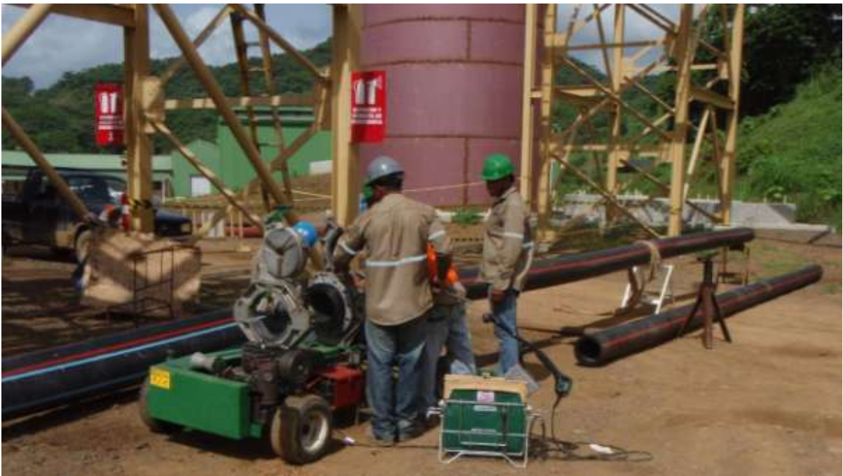
Las Lagunas - Line welding
