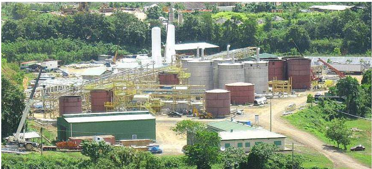
Las Lagunas - Plant Overview
