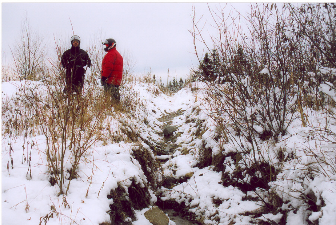
Vue d'un fossé creusé par les compagnies forestières sur la propriété Caber
