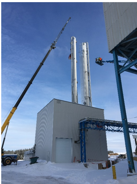
Unité de démonstration de 30 tonnes par jour de CO 2 Solutions Lors de sa construction à Saint-Félicien, Québec
