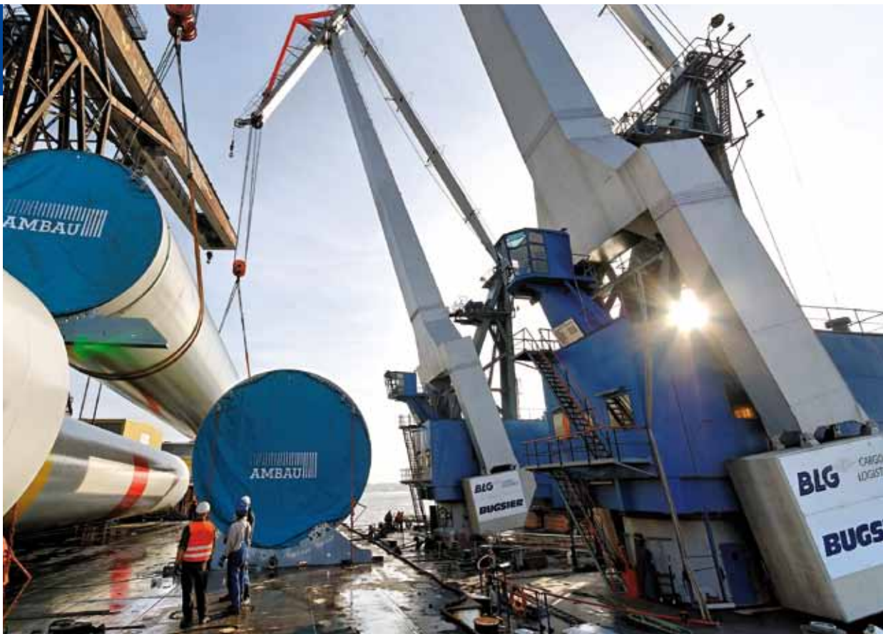
Verladung von Offshore-Turmsegmenten im Neustädter Hafen, Bremen
