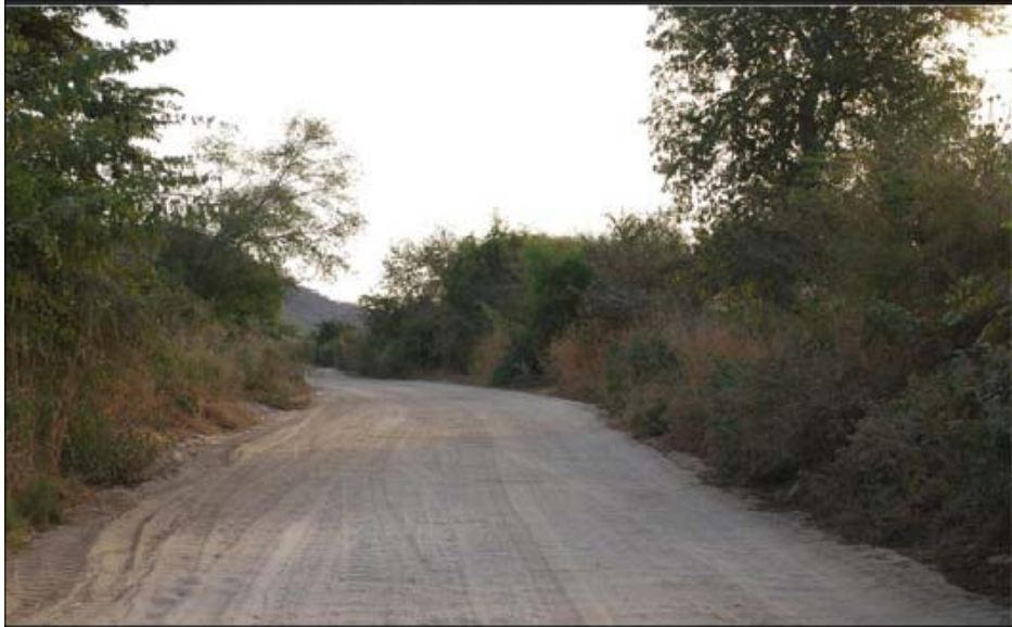
3. Dirt Road: Palmarito - El Gallo Project (8 miles)
