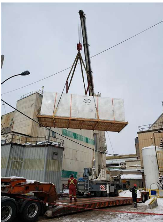
Figure – La construction de l'Usine de démonstration de purification a commencé.
