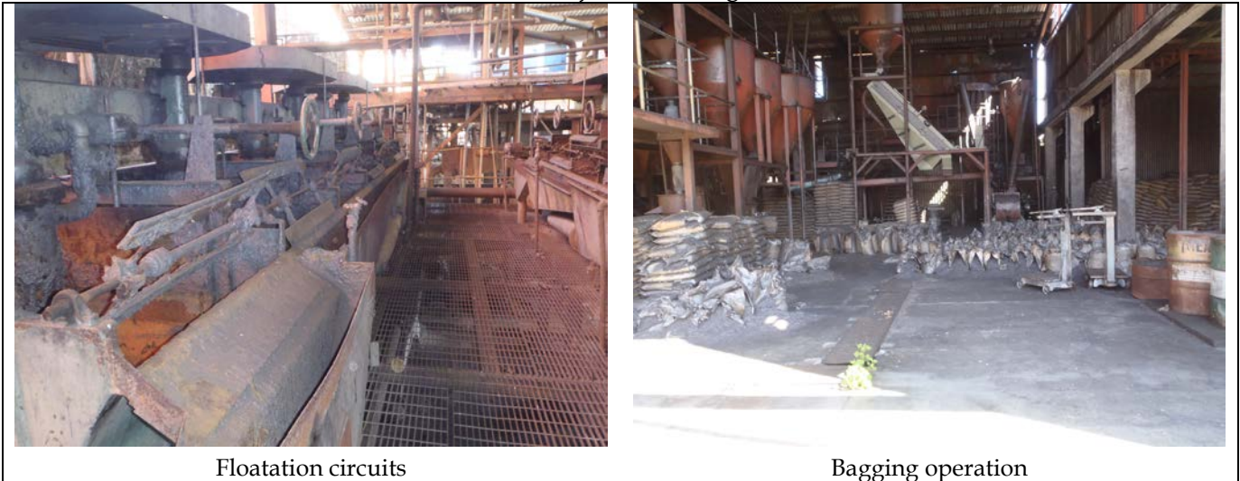
Plate 2. El Tejon Processing Plant
